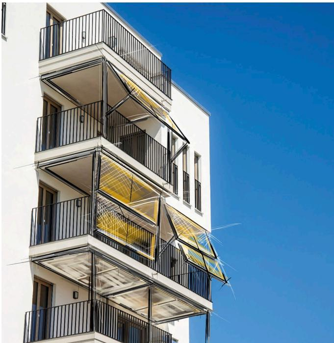
BU: Markisen mit Photovoltaikzellen bieten eine innovative Lösung für die Energiewende. Sie zeigen, wie sich etablierte Technologien wie der Sonnenschutz weiterentwickeln können, um den Anforderungen einer nachhaltigen Zukunft gerecht zu werden.
